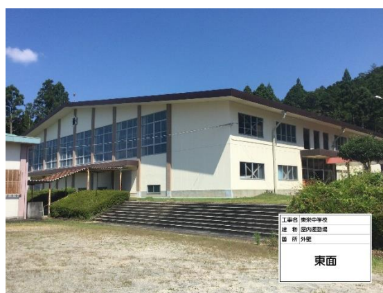
(東栄中学校) 屋内運動場の耐震補強工事
