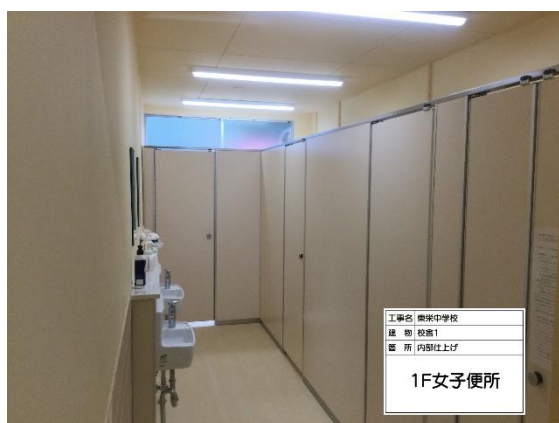
(東栄中学校) 校舎のトイレ改修工事
