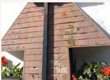
外壁板の状態
