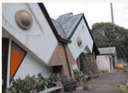
外壁の塗装状態
