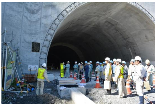
佐久間第1トンネル浦川側坑口
