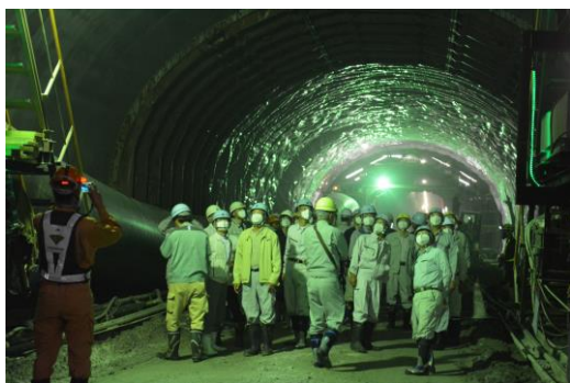
三遠道路3号トンネル東栄地区工事現場
