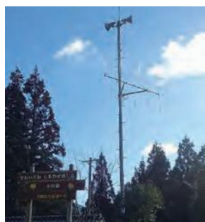
設楽町平山の防災行政無線
