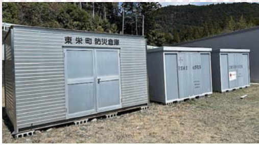
役場職員駐車場にある防災倉庫
