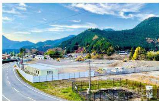
無床診療所等の建設現場
