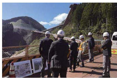
設楽ダムの建設現場
