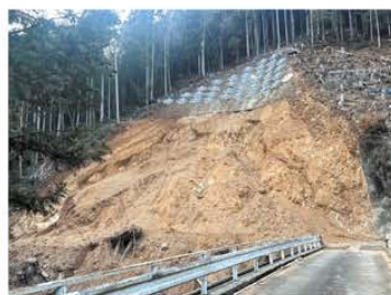
古戸災害復旧現場
