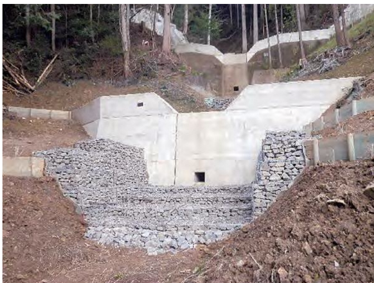
東栄町の治山事業施行地(三輪地区)
