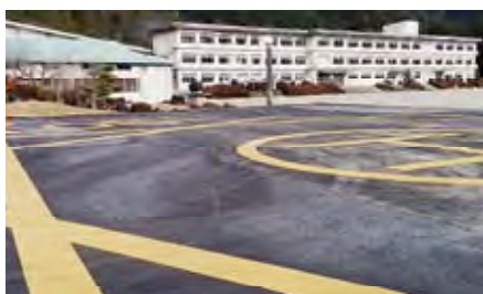
ヘリポートから見た中学校校舎
