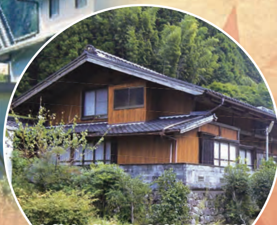
定住促進空き家(振草小林) 改修工事経費 550万円
