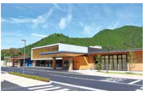
東栄町保健・医療・福祉複合施設 東栄ひだまりプラザ
